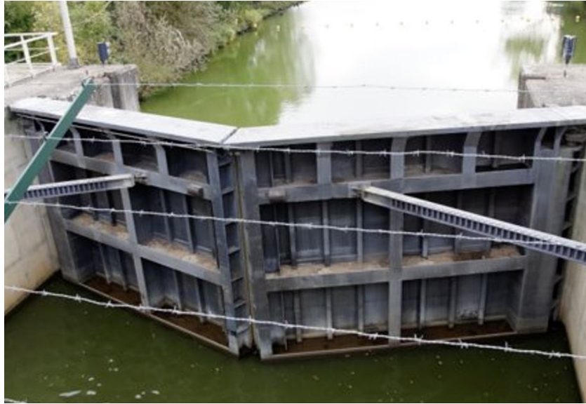
Figuur 2 3: Foto van de stalen puntdeuren
