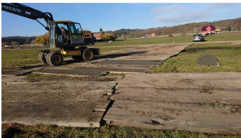
Figuur 7.3: voorbeeld van een kraan op rijplaten
