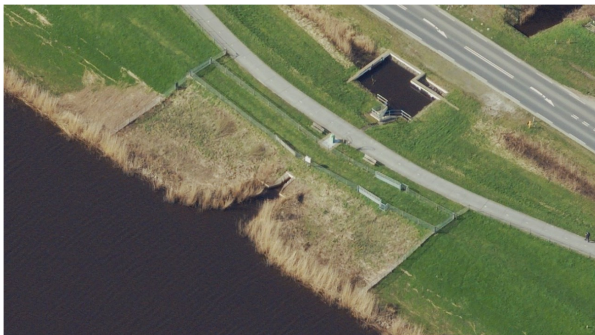
Figuur 2.1: bovenaanzicht inlaatwerk Repelweg
