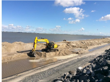
Afbeelding 4.4 Hydraulische graafmachine t.b.v. ontgraven aanzanding
