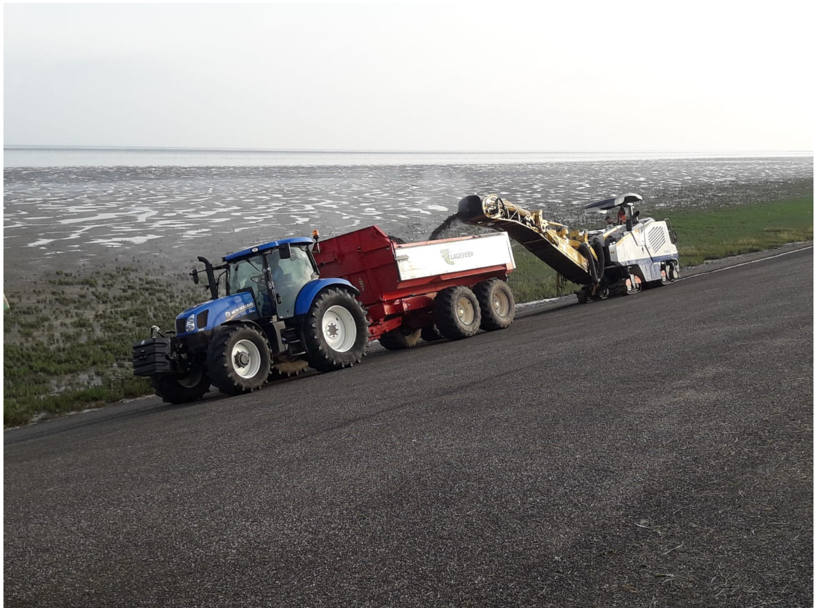
Afbeelding 4.3 Asfaltfrees en dumper t.b.v. verwijderen asfalt
