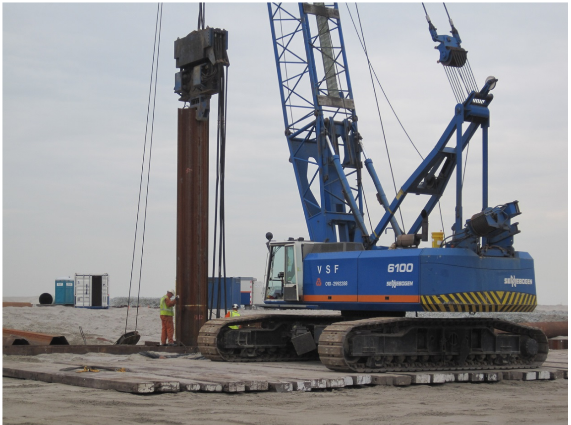
Afbeelding 4.1 Voorbeeld van aanbrengen damwand met draadkraan
