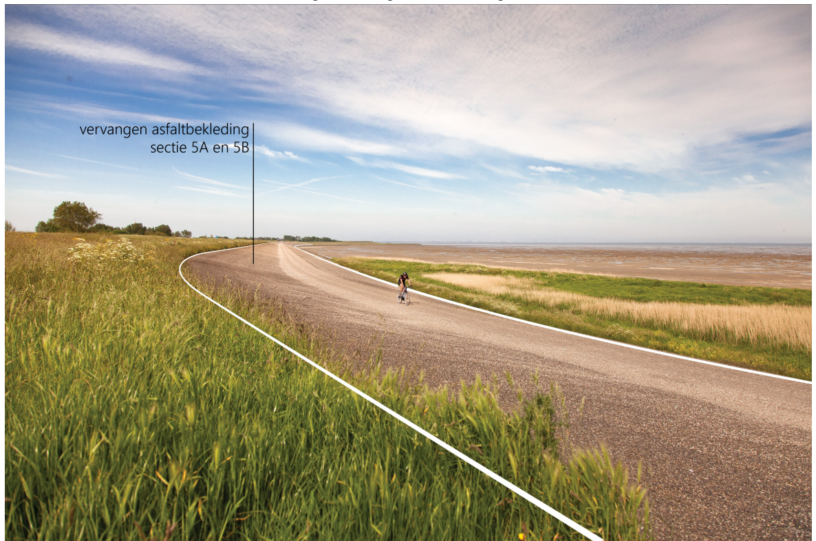
Afbeelding 2.6 Vervangen asfaltbekleding (sectie 5)
