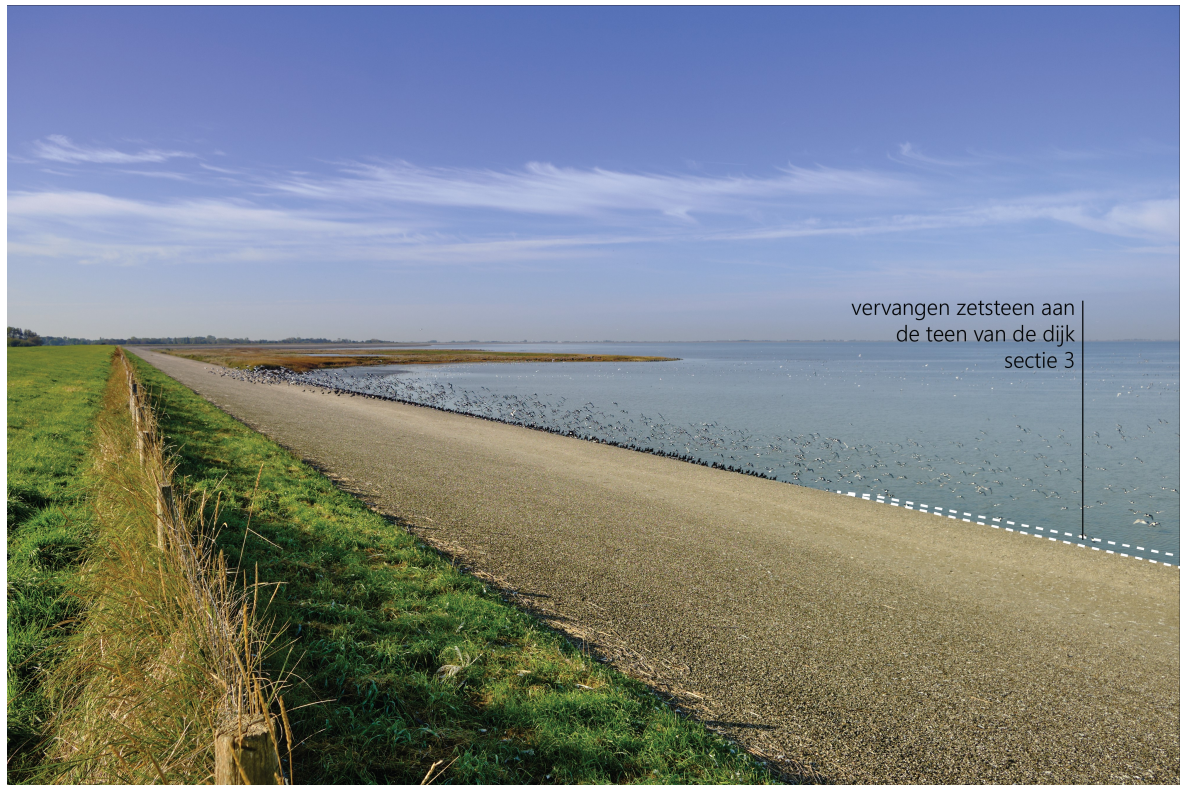
Afbeelding 3.16 Vervangen zetsteen (sectie 3)
