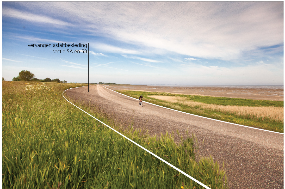
Afbeelding 3.18 Vervangen asfaltbekleding (sectie 5)
