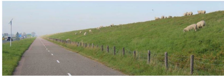
Afbeelding 3.10 Amsteldiepdijk aan de binnenzijde met binnendijs de N99
