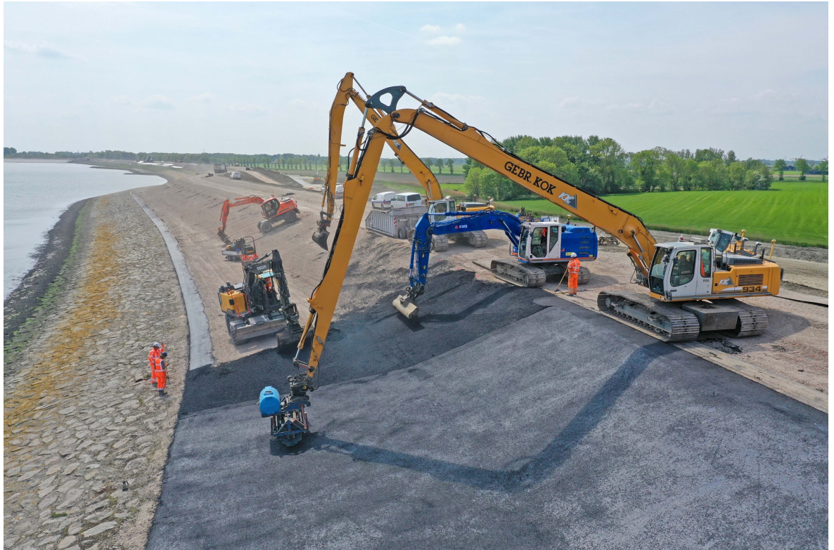
Afbeelding 4.5 Voorbeeld aanbrengen waterbouwasfalt met hydraulische graafmachine
