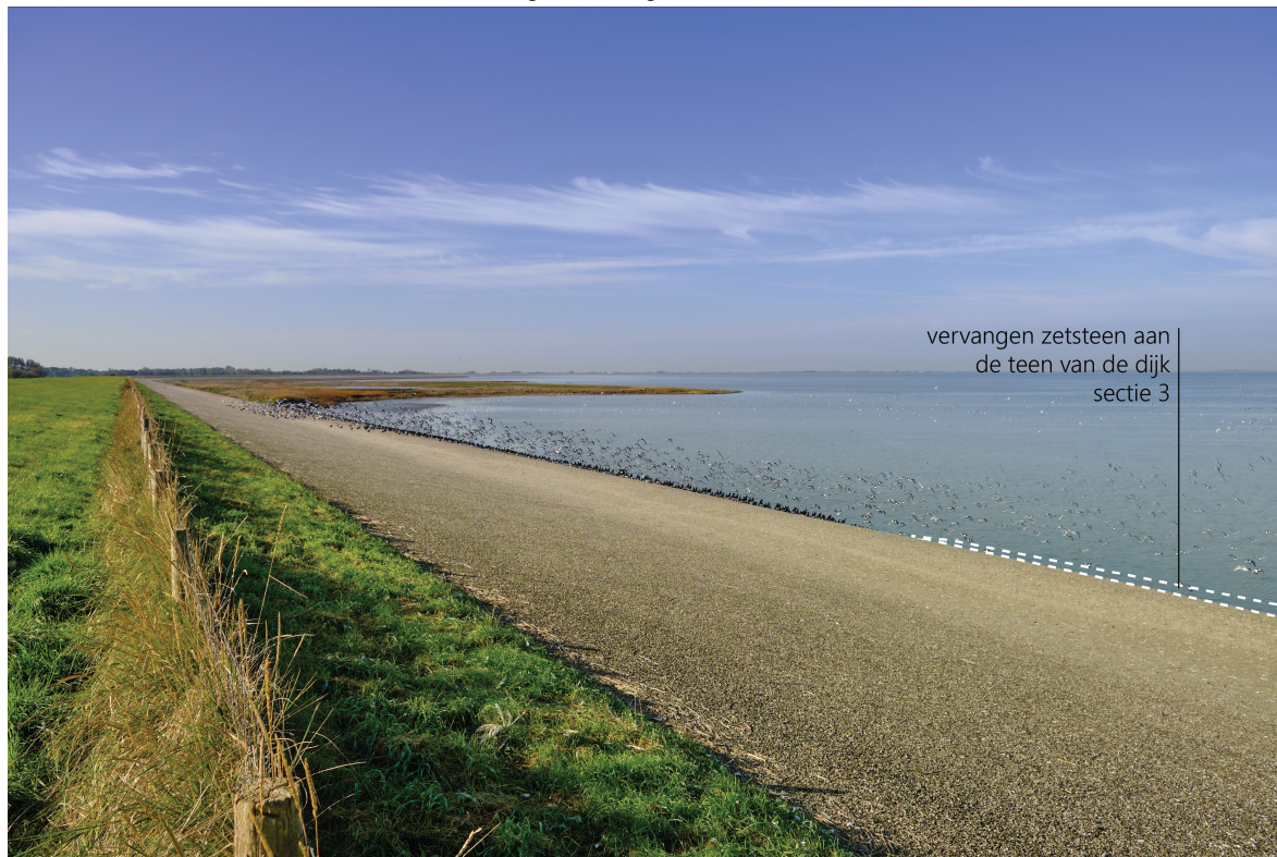
Afbeelding 2.4 Vervangen zetsteen (sectie 3)
