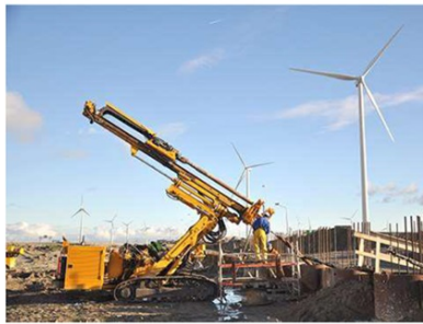
Afbeelding 4.2 Voorbeeld van aanbrengen groutankers met ankerboormachine
