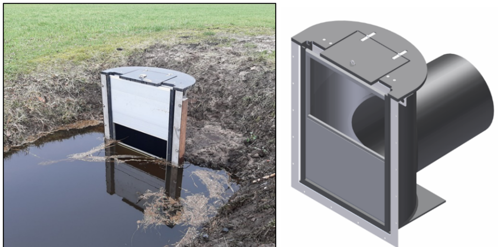
Figuur 1: voorbeelden van een kunststof stuwput met aluminium schotjes.
