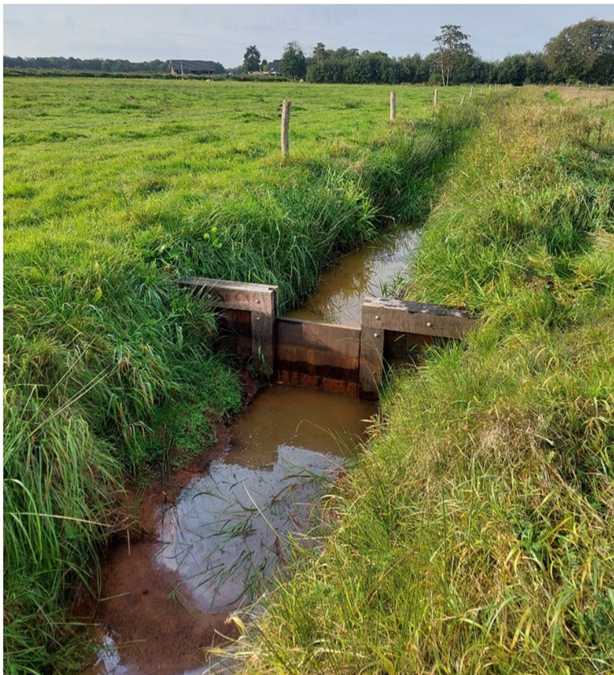
Figuur 3: schotbakstuw volledig uitgevoerd in hout.
