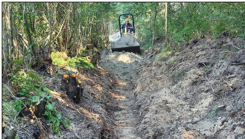
Figuur 8: verhogen slootbodem in uitvoering.
