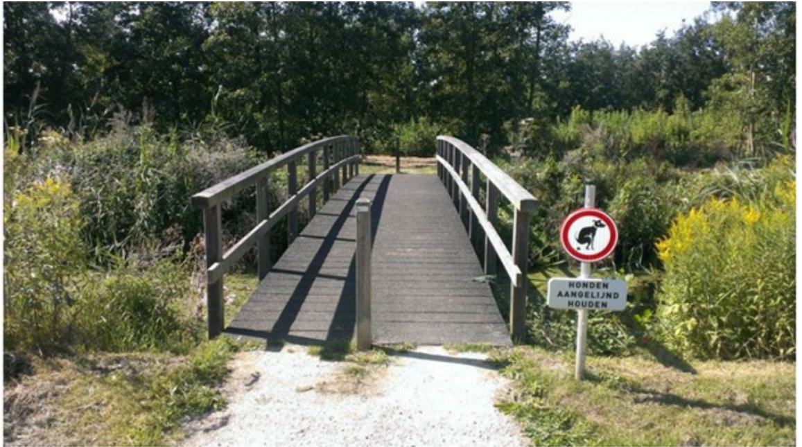
Afbeelding 5: Overige permanente bouwwerken in de watergang
