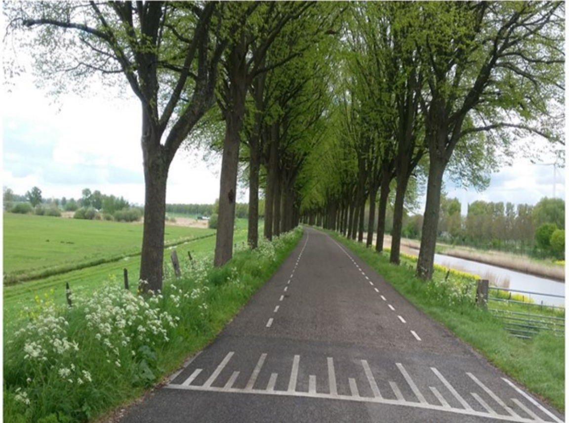
Afbeelding 7: Rij bomen op de kering, binnen en buitenzijde talud in waterstaatswerk
