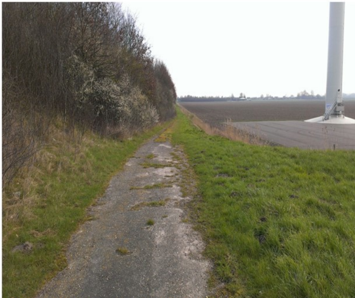
Afbeelding 20: Beschadiging grasmat met verharding daaronder
