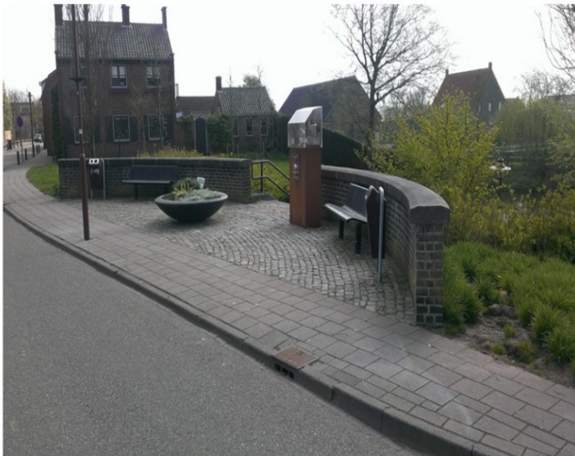
Afbeelding 10: Obstakels overig op de kering
