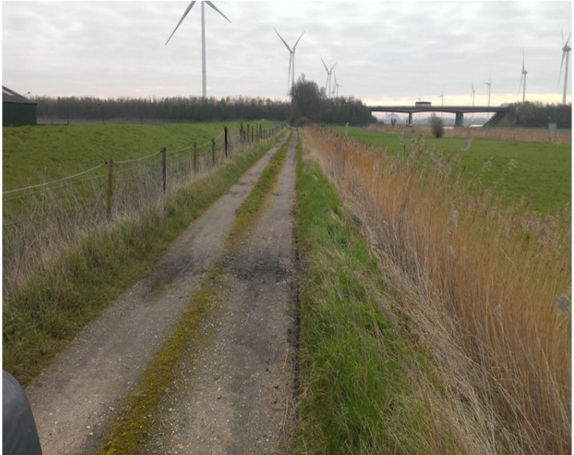
Afbeelding 21: Beschadiging grasmat met verharding daaronder
