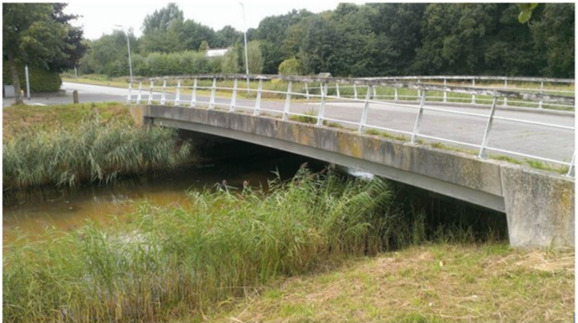
Afbeelding 6: Overige permanente bouwwerken in de watergang
