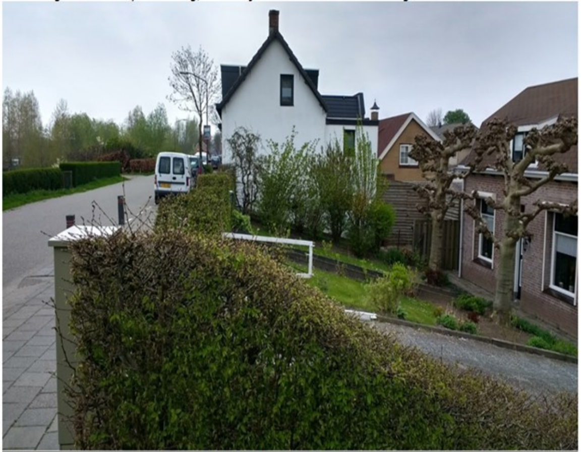
Afbeelding 9: Tuinen op de kering, buitenzijde talud zonder bebouwing
