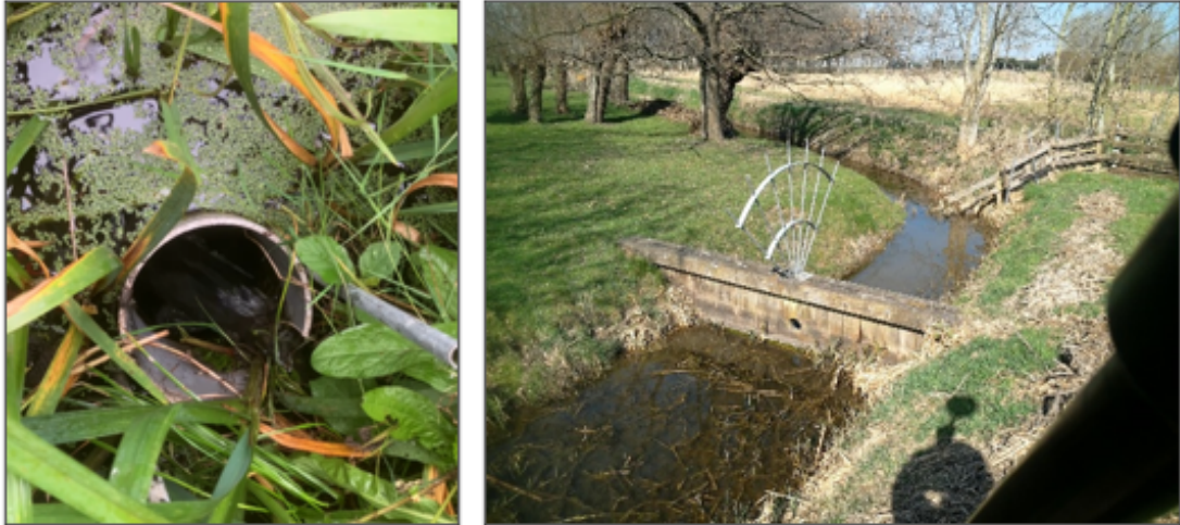
Figuur 4 - Overstort op de peilgrens tussen Kralingerpolder en Dorppolder op hoogte NAP -1,85 m (links) en keerschot met een gat op NAP -2,40 m juist benedenstrooms van deze peilgrens (rechts).
