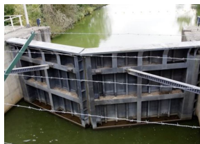
Figuur 2 3: Foto van de stalen puntdeuren
