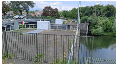
Figuur 2 4: Zicht op het sluisplateau met bestaande hekwerken
