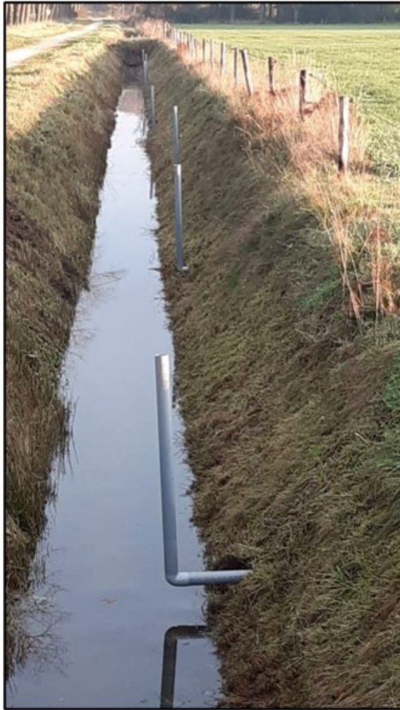
Figuur 6: Voorbeeld van draaibare bochten op bestaande drainagebuizen.
