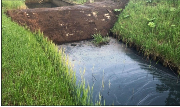
Figuur 7: Voorbeeld van afgesloten watergang met gronddam.
