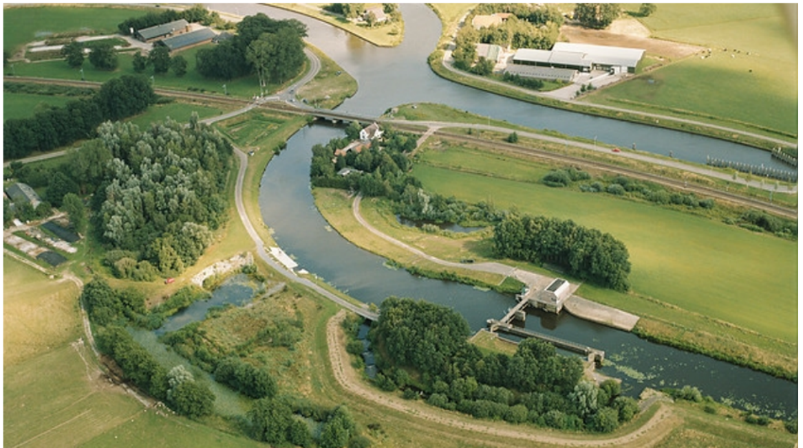
Figuur 1: Overzicht van sluis De Haandrik op de Vecht (Foto: waterschap Vechtstromen)
