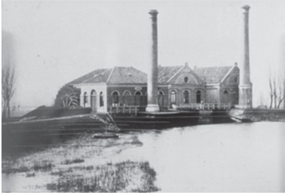
De naast elkaar liggende stoomgemalen IJserman (1870) en rechts Van Gennep (1876). Bij de overgang op dieselmotoren in 1916, werd het linker gemaal buiten gebruik gesteld en voor het grootste deel gesloopt, net als de schoorstenen. bron: Tijdschrift voor Waterstaatsgeschiedenis 8 (1999); webversie 2006.
