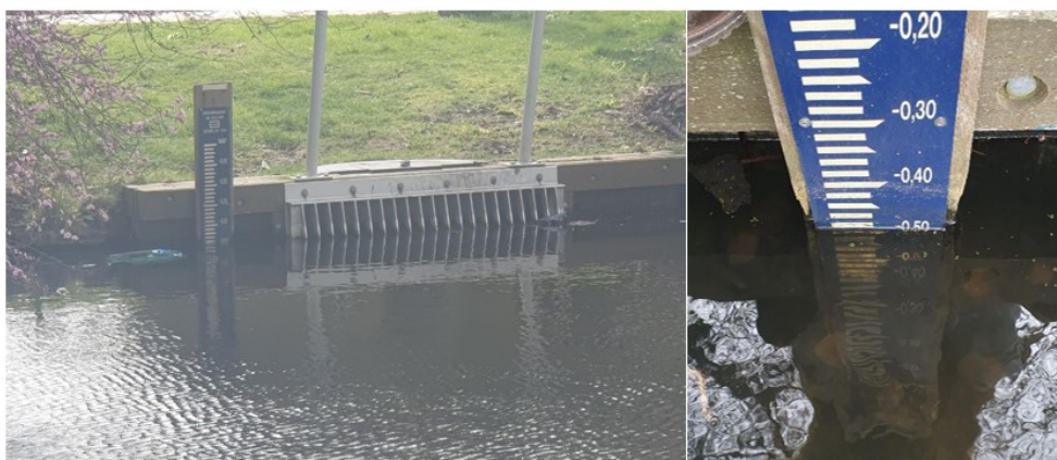
Figuur 3; foto van de aangelegde stuwput aan de Händellaan . Genomen in maart 2023
