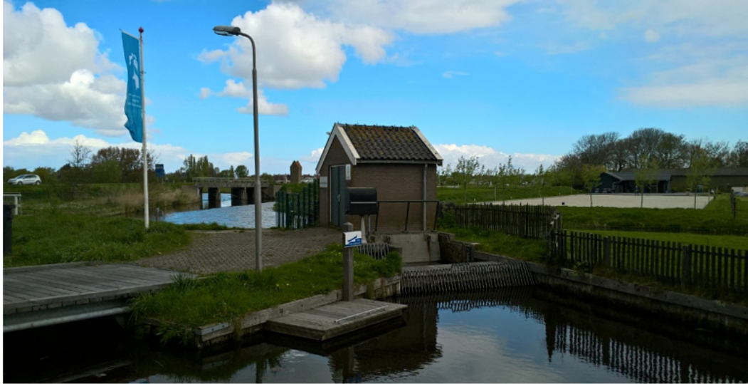
Figuur 1: Gemaal Groot-Limmerpolder Zuid
