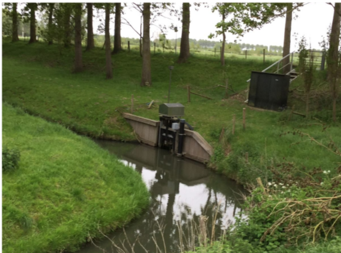
Figuur 2: Huidige stuw Bouwdijk en duiker MAI gezien vanaf de Kraaijenissedijk.
