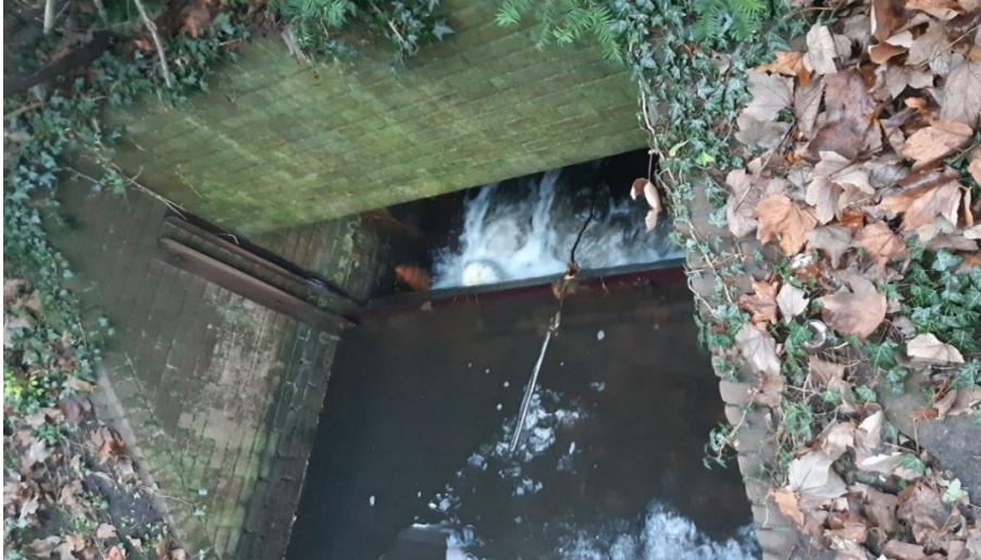
Figuur 2.11: Stuw vóór de overkluizing achter de Reitzstraat
