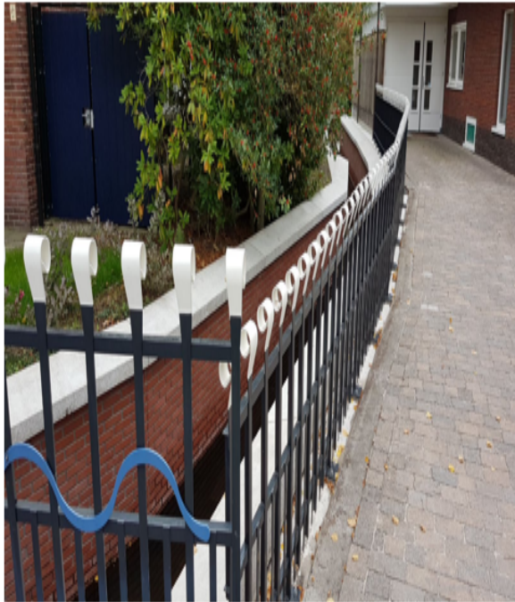
Figuur 3.2: Voorbeeld grondkerende constructie (kademuur) met hekwerk
