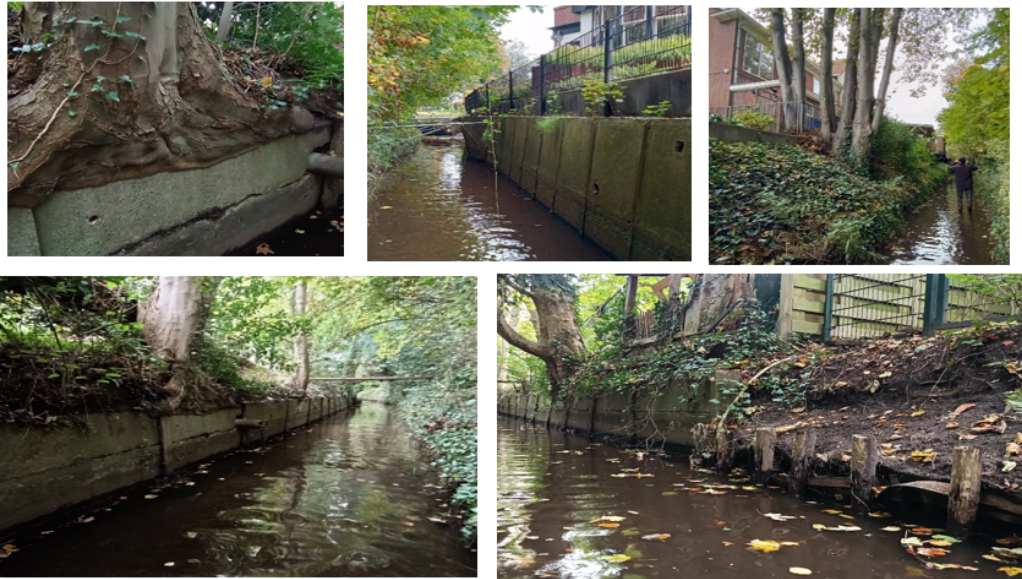
Figuur 1.1: impressie huidige situatie, knelpunten beheer en onderhoud, urgente schades aan kademuur
