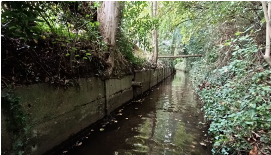
Figuur 2.10: impressie oever Drienerbeek, in benedenstroomse richting
