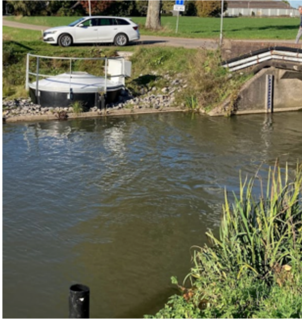
Figuur 5 Voorbeeld van een constructie voor vispasseerbaarheid waterschap Rivierland (foto N. Hoekman)
