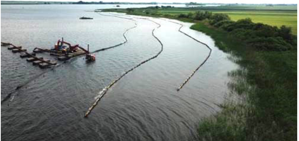
Figuur 1 Aanleg ondiepe zone in de Kûfurd
