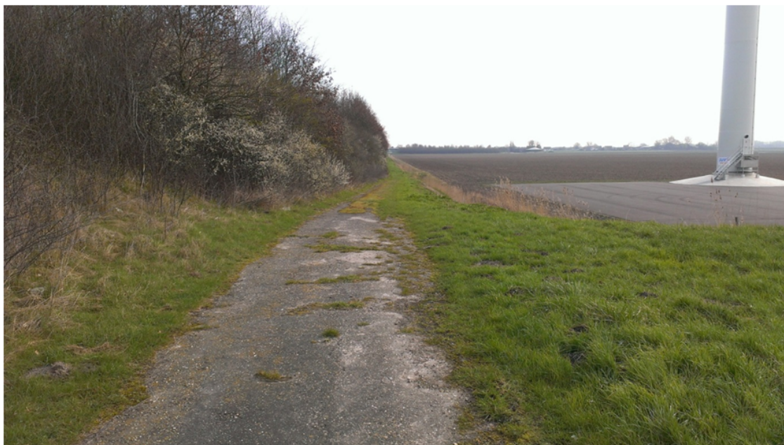
Afbeelding 20: Beschadiging grasmat met verharding daaronder
