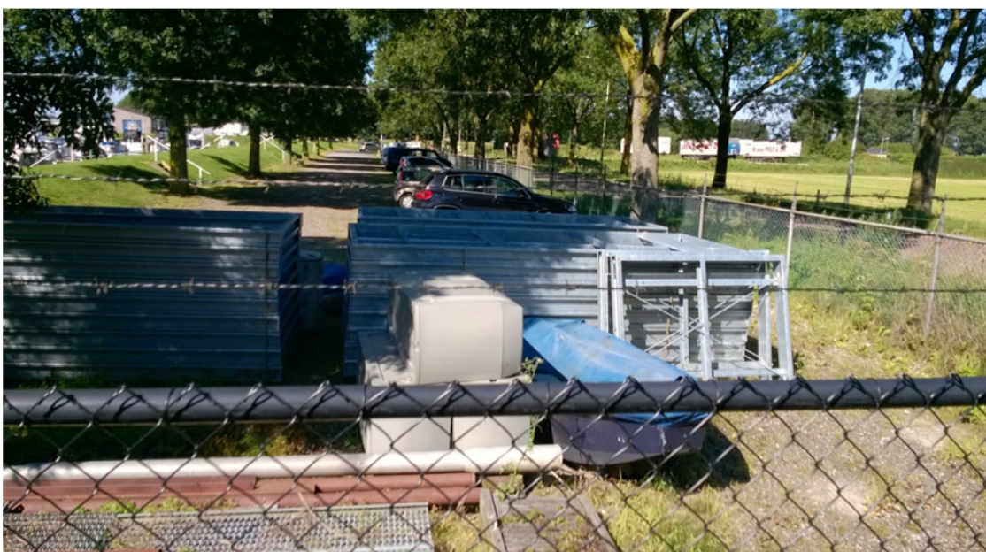
Afbeelding 19: Niet permanent bouwwerk (ongefundeerd) op kering, geplaatst op verharding
