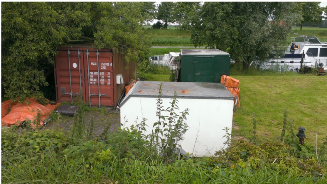
Afbeelding 18: Niet permanent bouwwerk (ongefundeerd) op kering, geplaatst op verharding
