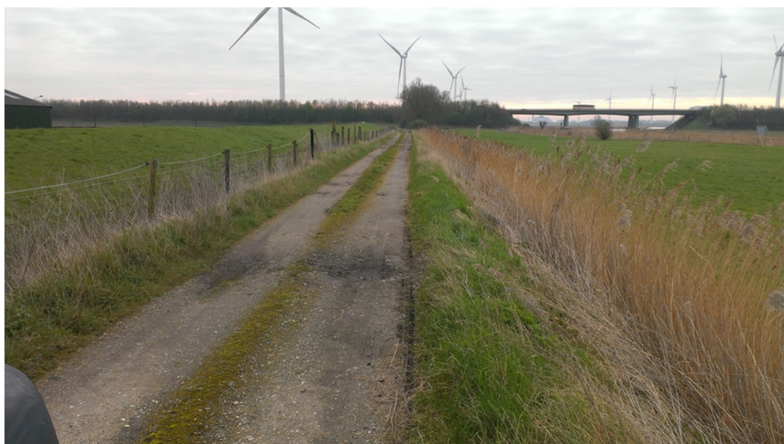
Afbeelding 21: Beschadiging grasmat met verharding daaronder
