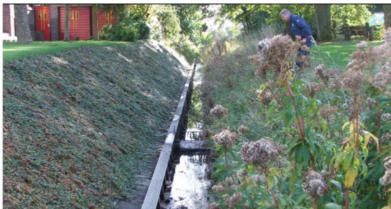
Figuur 3.1 Krap gedimensioneerde hoofdwatgang tussen Wadwerderweg 11 en 13 bij de stuw
