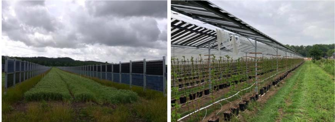
Figuur: verticale bifaciale agrivoltaïcs bij gewassenteelt tussen de panelen (links) en overkappende agrivoltaïcs met teelt van zacht fruit onder de PV-panelen (rechts).
