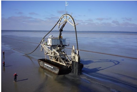
Een voorbeeld van een Wadtrencher - Er is samen met het NIOZ en Wageningen Marine Research onderzoek gedaan naar de inzet van deze Wadtrencher om de effecten op de natuur en ecologie te minimaliseren.
