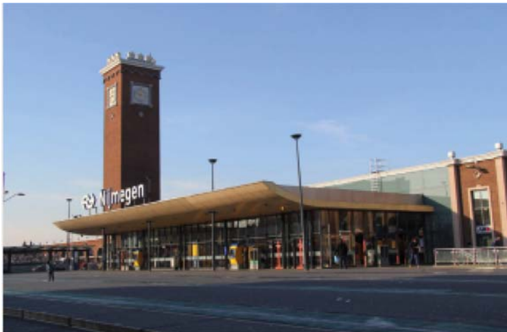
Figuur 6 Huidige exterieur stationshal
