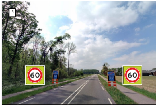
Komgrens Brommelen -A0160fs monteren in komportaal A0460 vervangen door A0160fs
