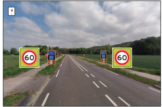
Komgrens Bunde -A0160fs monteren in komportaal A0460 vervangen door A0160fs
