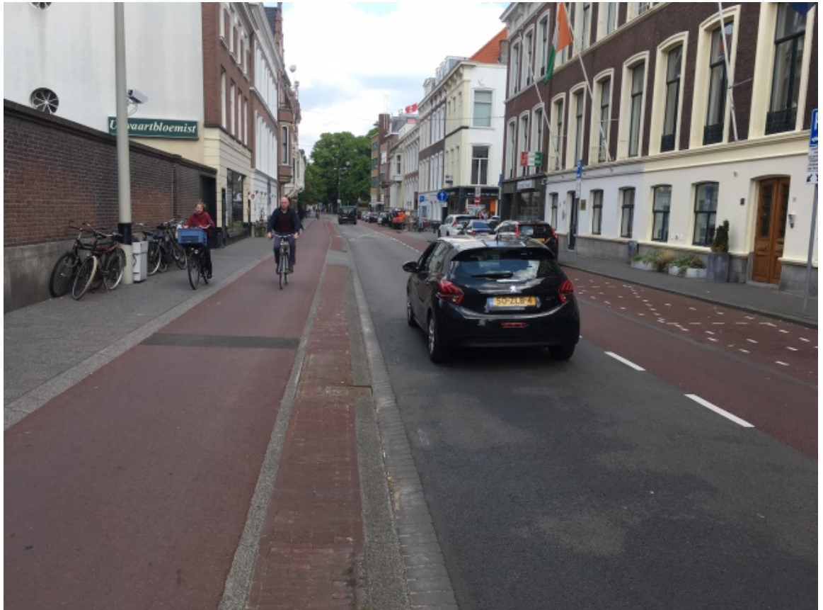
Figuur 8. Referentiebeeld van een profiel met een fietsstrook met het auto verkeer mee en een vrijliggend fietspad met schrikstrook tegen het auto verkeer in (voorbeeld Laan van Meerdervoort)
