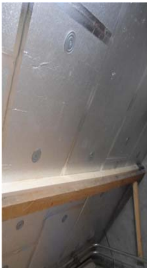
Afb. 6 Isolatie op vliering tussen de gordingen
