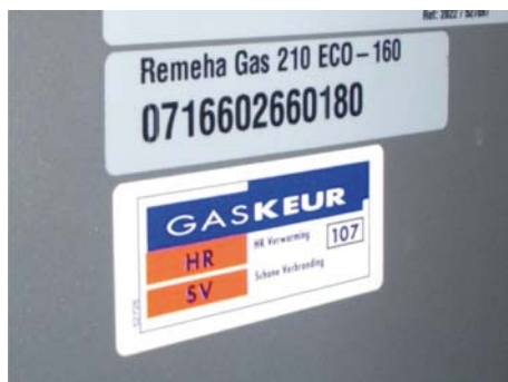
Afb. 9 CV-ketel met HR keur (HR107)
