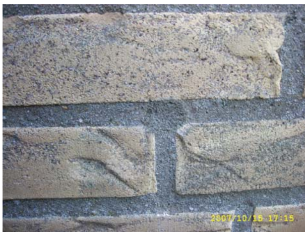
Afb. 3 Boorgat in de gevel
