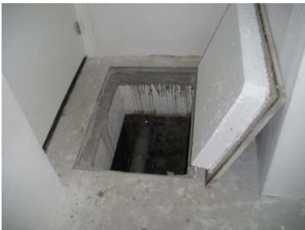
Afb. 7 Isolatie in de vloer
