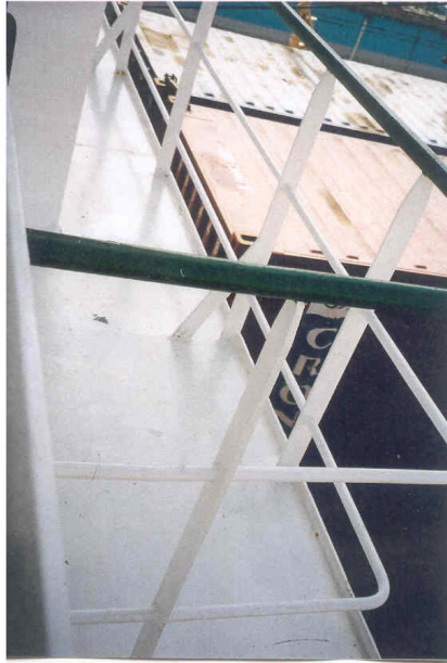
De leuninghoogte aan boord van de "Maasdiep" bedraagt 1.10 meter. Tevens is het hekwerk uitgerust met twee tussenspijlen.
