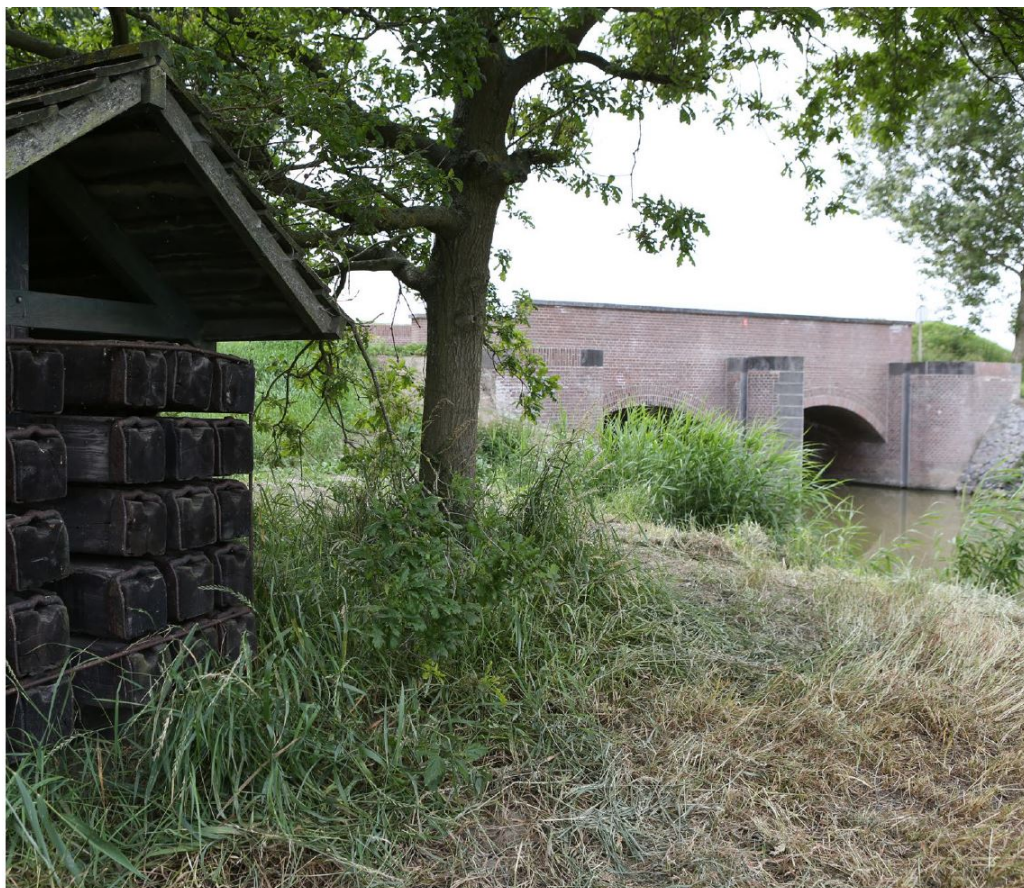
Damsluis met schotbalkenloods in de Molentocht bij de Vuurlinie in de Wijkermeerpolder (foto Kenneth Stamp,
