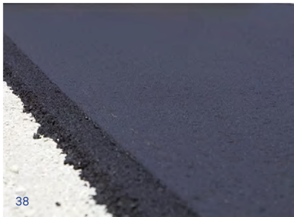
Wegprofiel van waterdoorlatend bio-asfalt
