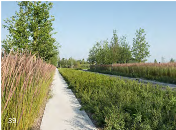
Fietsprofielen gemaakt van hergebruikte betonplaten
