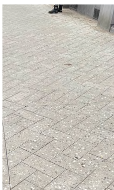
Steen gemaakt van hergebruikt materiaal
