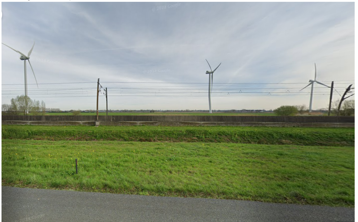
Afbeelding 2.8 Zicht windpark Buren vanaf A15
