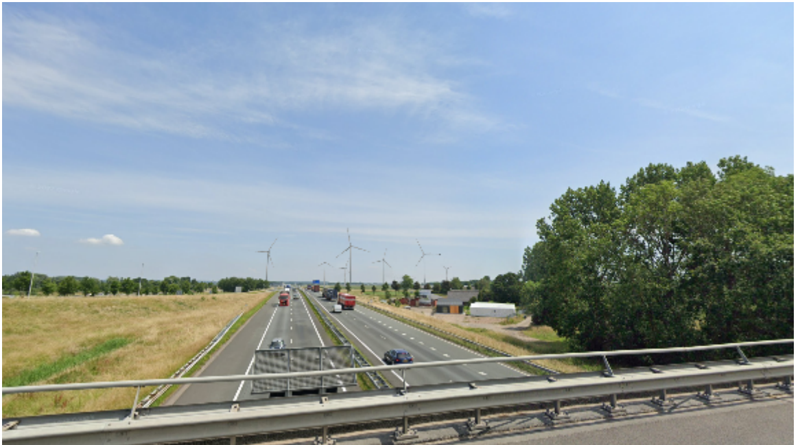
Afbeelding 5.30 Visualisatie 4, bovengrens. Positionering op de N323, vanaf de infrastructurele bundel. Zicht in oostelijke richting
