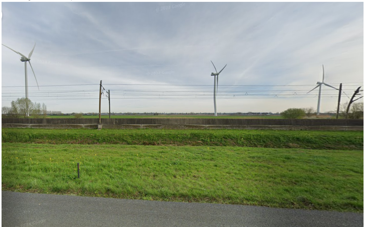
Afbeelding 2.8 Zicht windpark Buren vanaf A15
