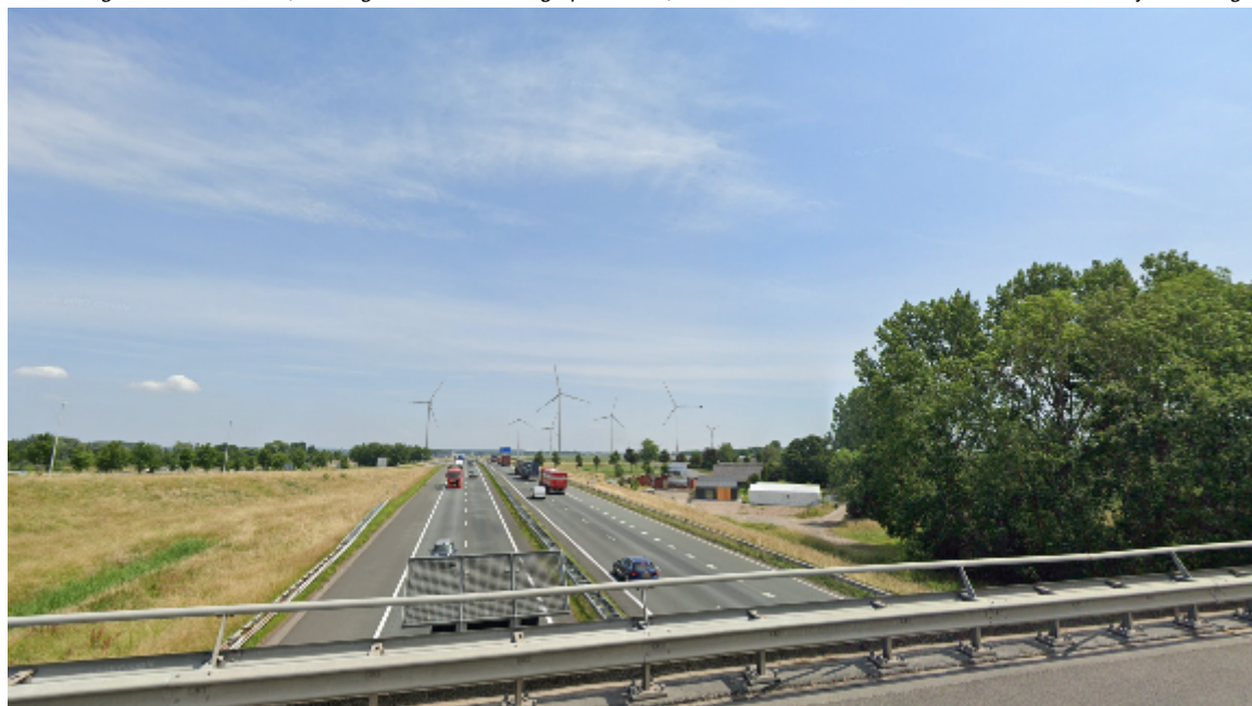
Afbeelding 5.30 Visualisatie 4, bovengrens. Positionering op de N323, vanaf de infrastructurele bundel. Zicht in oostelijke richting
