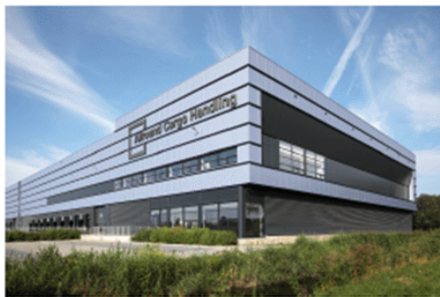
Allround cargo Handling, Ridderkerk (bron: FALK® Bouwsystemen)
