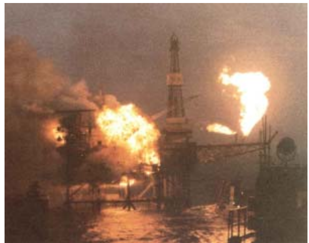
Het Piper Alpha platform, circa 20 seconden nadat de vrijgekomen brandstof ontstoken werd en een eerste explosie veroorzaakte. Het verblijf van de bemanning en de daaraan hangende vluchtboten was onmiddellijk ingesloten door een wolk van vuur en rook (foto: Department of Energy, The Public Inquiry into the Piper Alpha Disaster, The Hon Lord Cullen, Volume two, November 1990)
