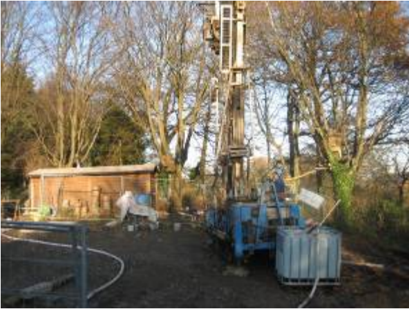
Beveiligingwerkzaamheden Schacht Kleurmarienhuis (foto: SodM)
