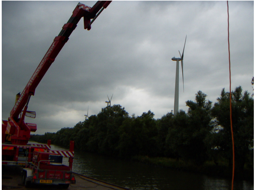
Figuur 3.2.2, locatie 1 op ca 50 meter uit de oever
