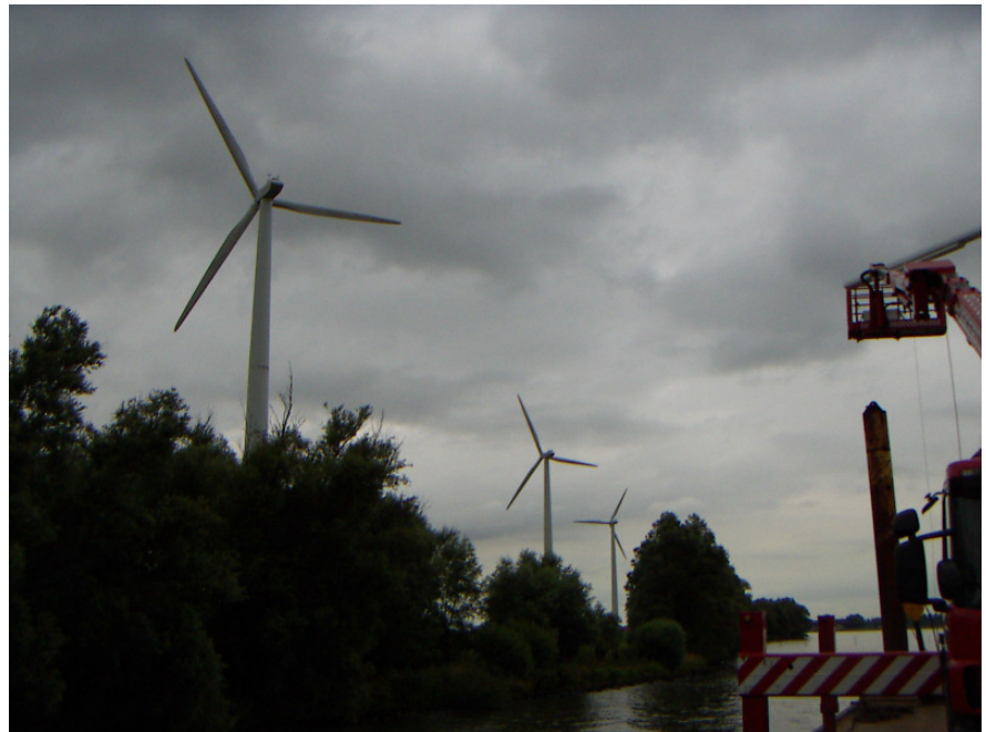
Figuur 3.2.1, locatie 1 op ca 50 meter uit oever.
