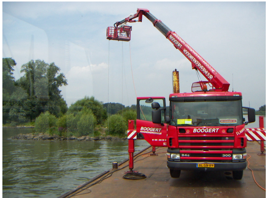
Figuur 3.6.1, ponton haaks op vaarwater tussen Moerdijkbrug en HSL - brug
