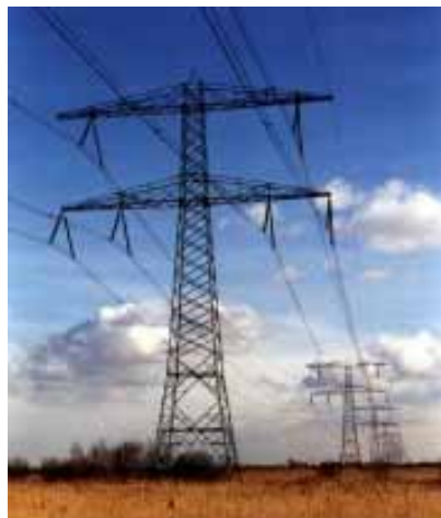
Figuur: Standaard dubbelcircuit 380 kV-mast
