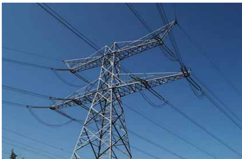
Figuur 2.6-1: Standaard dubbelcircuit 380 kV-mast
