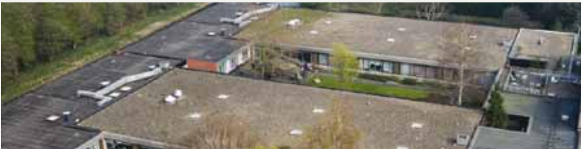
Platte daken zijn warme daken
