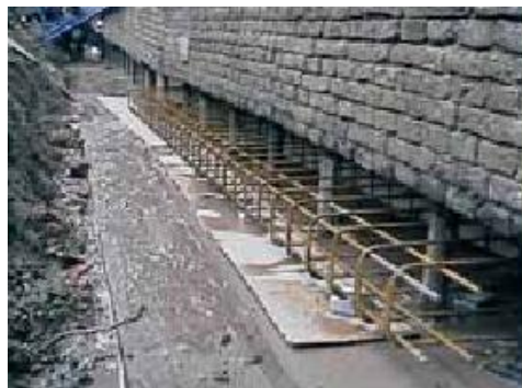
Foto 1: aanbrengen van wapening voor funderingsbalk Bron: C.J. Smit
