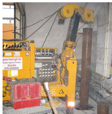
Foto 4: opstelling voor het plaatsen van palen
