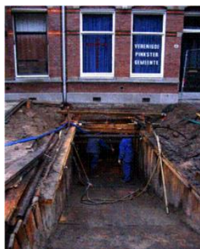
Foto 5: aanbrengen van hellingsbaan voor toegang materieel (Bron: hoogwerff)
