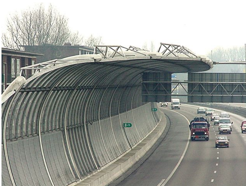
Figuur 2.18: luifelconstructie tegen geluidsoverlast op de A16 bij Dordrecht
