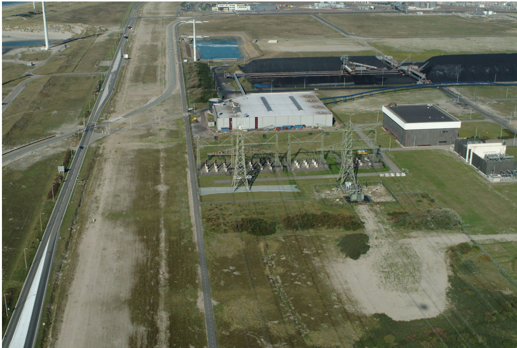
Foto 10.2 Overzicht E.On-centrale en omgeving
