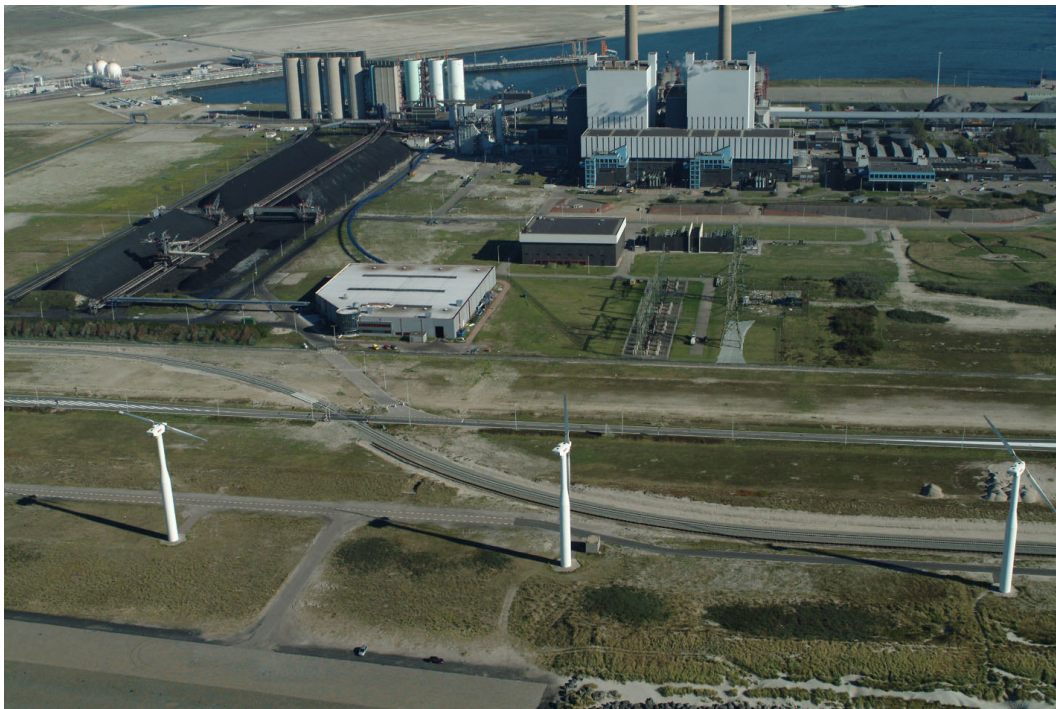
Foto 10.1 Overzicht E.On-centrale en omgeving
