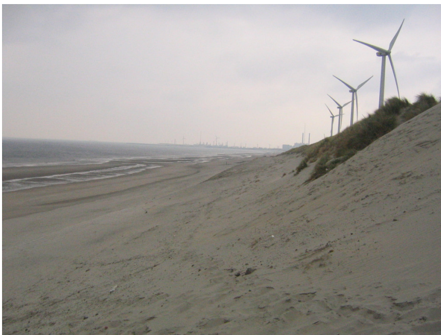
Foto 8.3 Oeververdediging Slufterdam (bron: Royal Haskoning)
