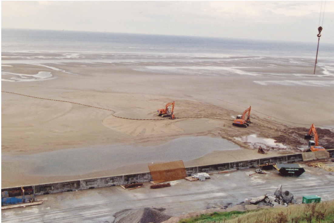
Foto 5.7 Ingraven van de kabel op het strand (bron: Metoc)
