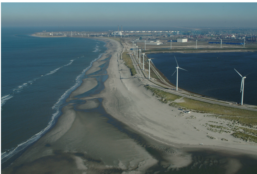
Foto 5.6 Locatie zuidelijke aanlanding, Slufterdam op rechterzijde foto (Bron: BritNed)
