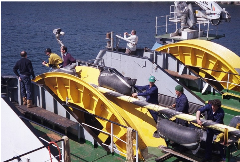
Foto 5.4 Op het legschip worden drijvers aan de kabel vastgemaakt (bron: Metoc)
