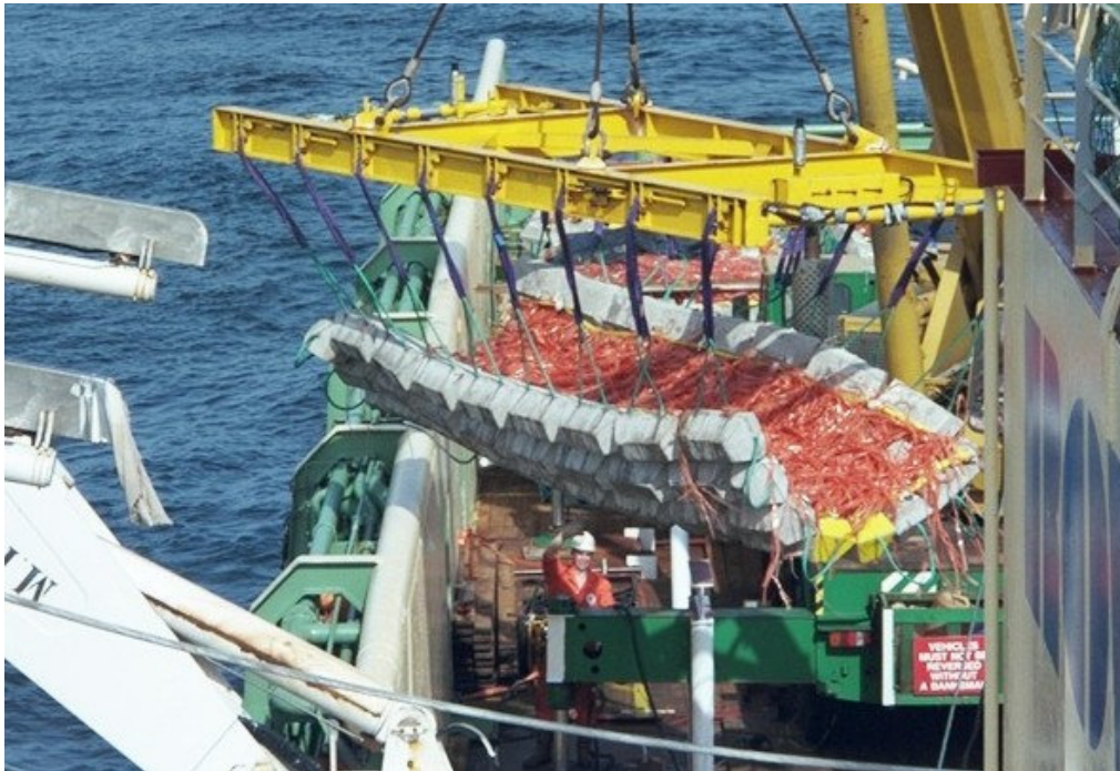
Foto 5.3 Een betonmatras wordt te water gelaten (bron: Metoc)
