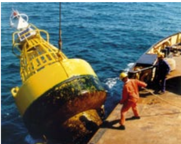
Het plaatsen van een boei
