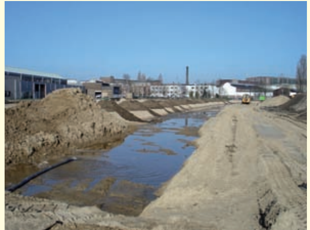
Aanleg waterpartij (foto: Projectbureau Hart van Zuid)
