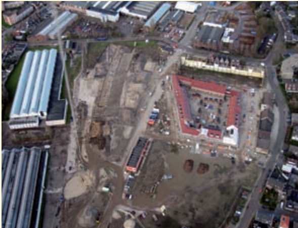
Overzichtsfoto saneringswerkzaamheden (foto: Projectbureau Hart van Zuid)
