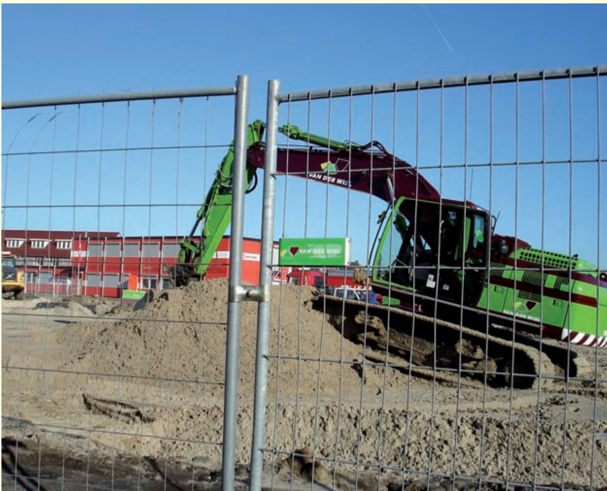
Sloopwerkzaamheden Hijschgebied en Esrein (foto: Projectbureau Hart van Zuid)
