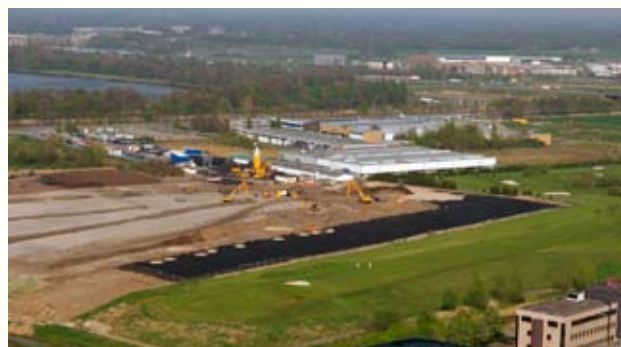
Foto 3: Uitbreiding van de golfbaan op de voormalige stortplaats Meerendonk in 's-Hertogenbosch (foto: Gert van Mil)
