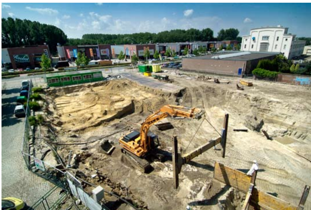
Foto 2.1: Overzicht van de sanering van het gasfabrieksterrein in Bergen op Zoom (foto: Marcel Bekken)
