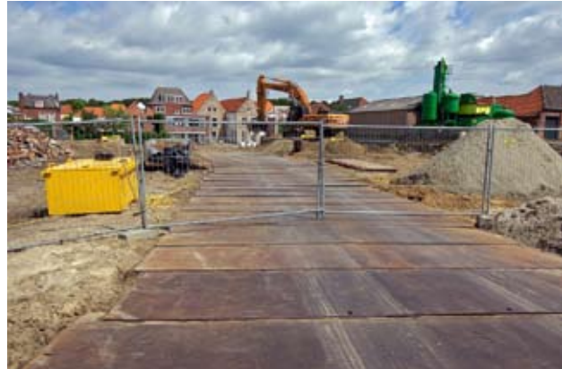
Foto 2: Sanering van het gasfabriekterrein in Bergen op Zoom (foto: Gert van Mil)
