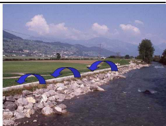
Abb.3 Die Nationalstrasse (N2) wirkt als Entlastungsgerinne und die Hochwasser-schutzmauer dient auch als Schallschutz
