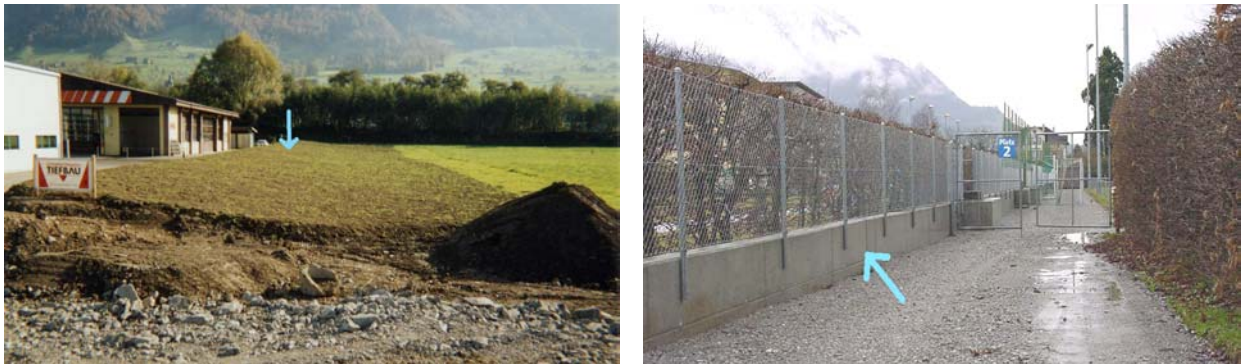
Abb. 8 und 9: Erdwälle und Mauern entlang des Entlastungskorridors Buochs / Ennetbürgen.
