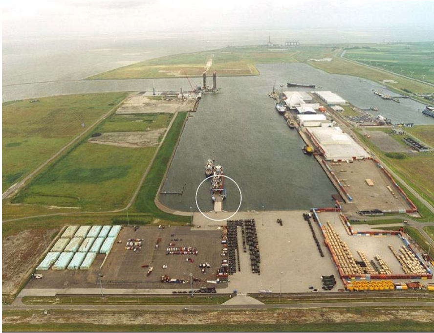
Eemshaven: mogelijke locatie voor een multifuelcentrale
