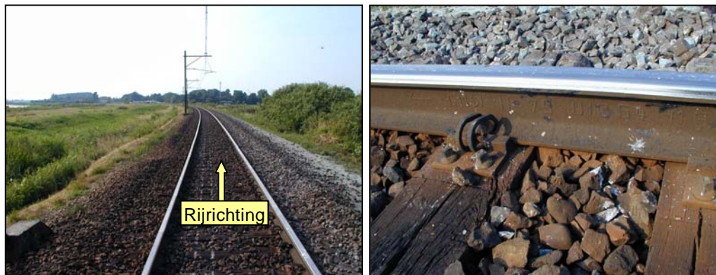
Afb. 9 en 10: overzicht boog en detailopname bevestiging met rughellingplaat.
