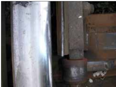
Afbeelding 11 & 12: de linker buitentong is geraakt en sluit niet aan.
