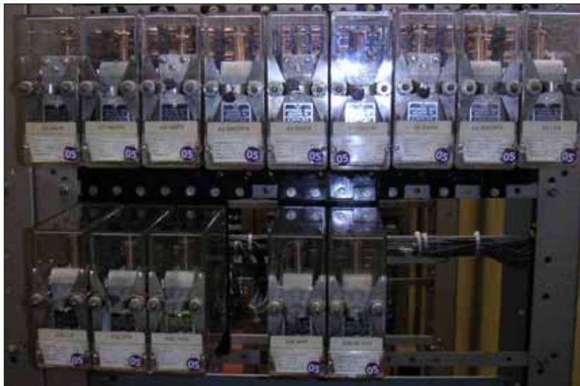
Afbeelding 14: De relais van wissel 63 in Relaishuis 10 te Amsterdam.
