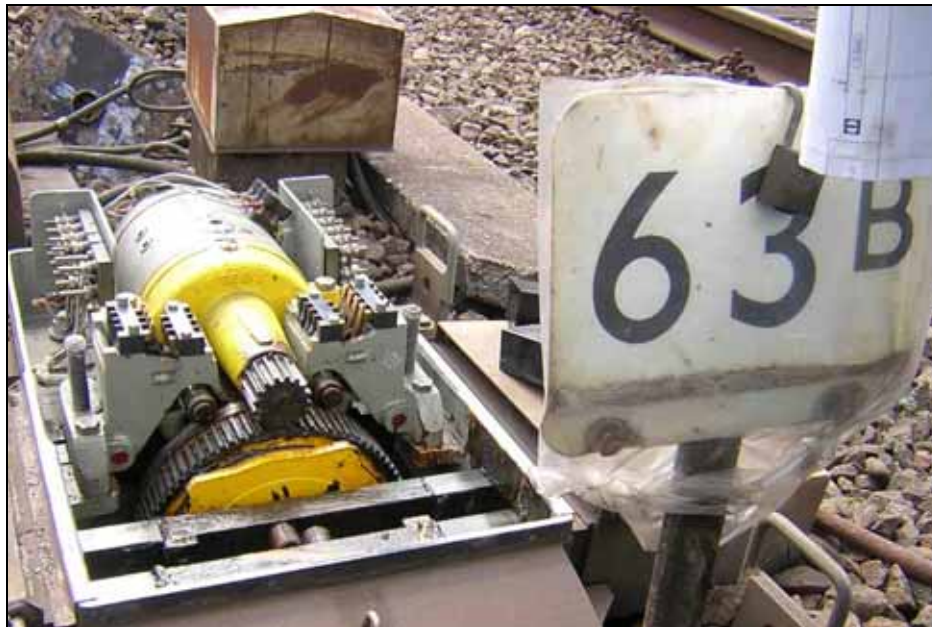
Afbeelding 13: Beeld van de geopende stellerkast van wissel 63B. Daarachter het wissel aansluitkastje.
