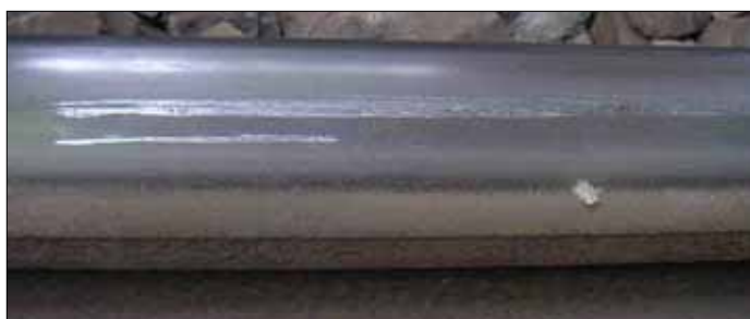
Afbeelding 17a/b: Krassen aangetroffen op de spoorstaven van spoor 3a.
