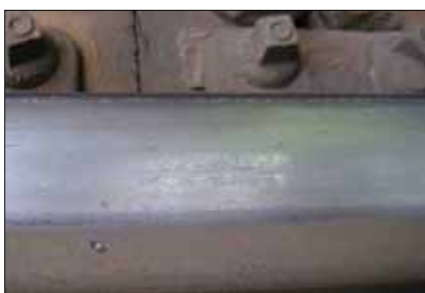
Afbeelding 17a/b: Krassen aangetroffen op de spoorstaven van spoor 3a.
