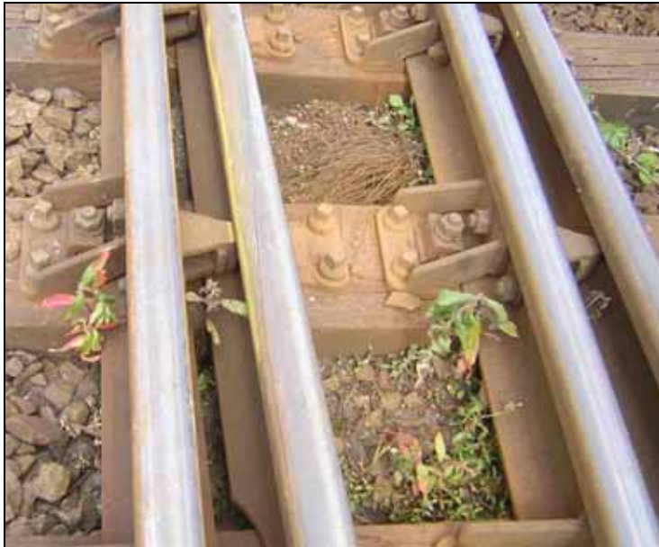
Afbeelding 10: Een scherpe kras geeft het begin van de ontsporing aan.
