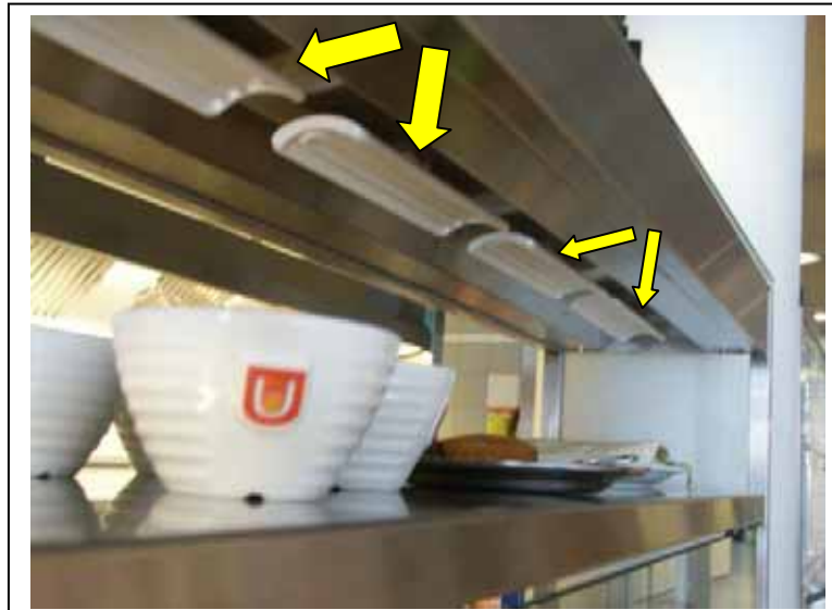
Figuur 36 Typische horeca-situatie met langgolvige IRB/IRC stralers zonder zichtbare rode gloed (zie ook 6.2.2 onder het kopje “IR-lampen”)
