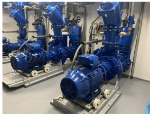
Nieuwe pompen gemaal Kerkstraat
