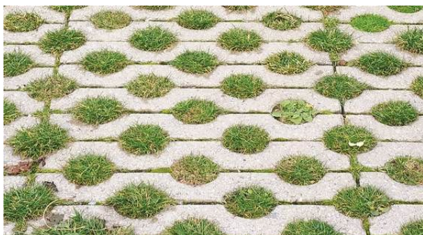
parkeerplaatsen in een waterpasserende steen
