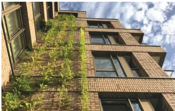
(5) beplanting op de gevel
