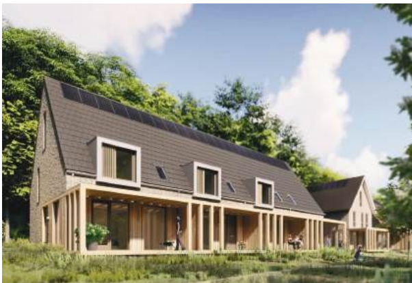
dakkapel als losse elementen toegevoegd
