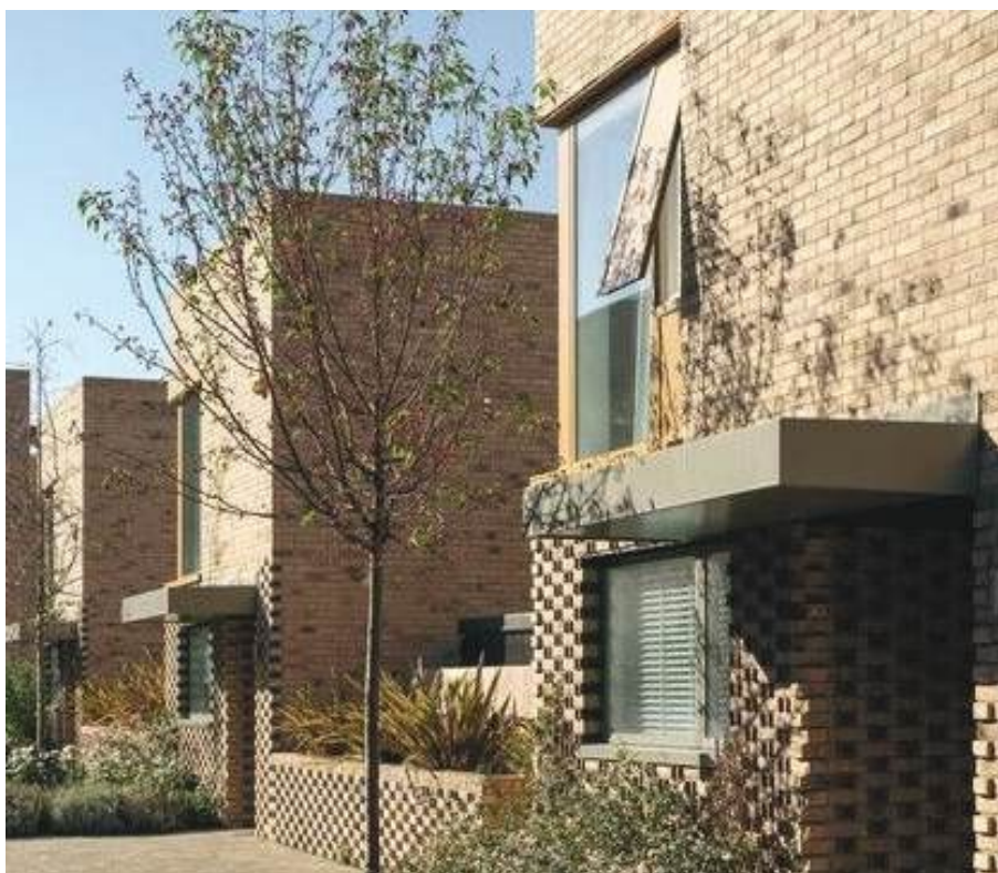
samenhang in beeld door eenduidige architectuur, materiaalgebruik en inzetten van verbijzonderingen
