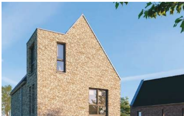
overgang de hoek om – dakopbouw
