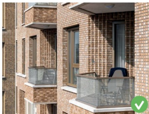
4.2.a. Wel: privacy op het balkon, bijvoorbeeld door afrastering - KAW architecten
